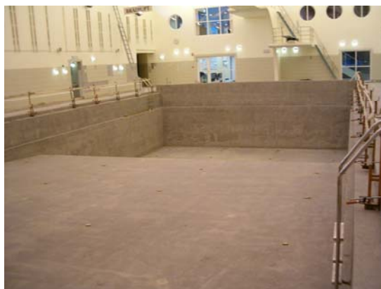
Bilde 2: Alle fliser måtte fjernes , underlaget sandblåses og sparkles før nye fliser blir limt med epoksy
