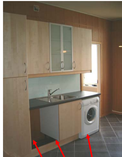
Våtzone i kjøkken som skal sikres med tett golv og lekkasjevarsling
