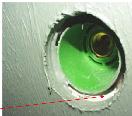
Figur 2: Ulike rørgjennomføringer ved dusjarmaturen. På noen typer er det komplisert både å få tetting rundt gjennomføringene og få forlenget armaturstussene.
