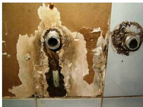
Figur 5: Ved eldre armaturer finnes mange vegg-gjennomføringer som ikke er egnet for å tette rundt.
