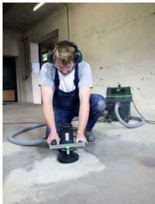
Figur 3a og b: Håndholdt maskin med påkoblet støvavsug er praktisk ved nedsliping av ujevnheter.
